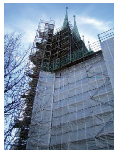
Kirche St. Severi, Erfurt Ausführung durch Teupe & Söhne Gerüstbau GmbH, Stadtlöhn Anforderungen: ca. 7.500 qm Arbeitsgerüst für Natursteinarbeiten einschließlich Turmeinrüstungen mit freitragenden Überbauungen, Schwerlastkonsolen, Aufzügen, Wetterschutzdächern und Sonderkonstruktionen
