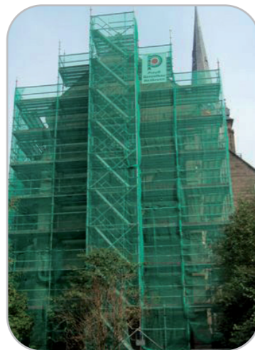
Kirche St. Severi, Erfurt Ausführung durch Teupe & Söhne Gerüstbau GmbH, Stadtlöhn Anforderungen: ca. 7.500 qm Arbeitsgerüst für Natursteinarbeiten einschließlich Turmeinrüstungen mit freitragenden Überbauungen, Schwerlastkonsolen, Aufzügen, Wetterschutzdächern und Sonderkonstruktionen
