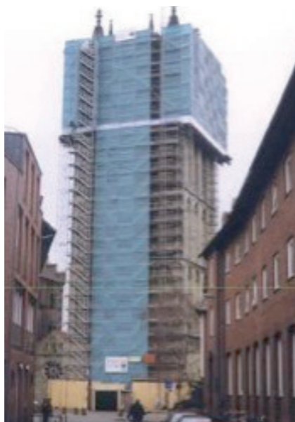
Überwasserkirche Münster Ausführung durch Teupe & Söhne Gerüstbau GmbH, Stadtlöhn Anforderungen: Gerüststellung einseitig am Turmschaft inklusive Treppenturm Stellung von Traggerüsten an den Turmecken Überbrückung in ca. 35 m Höhe mit Hilfe von Stahlträgern zur Aufnahme von Arbeitsgerüsten und weiterer vierseitiger Gerüststellung zur Bearbeitung des oberen Turmdrittels
